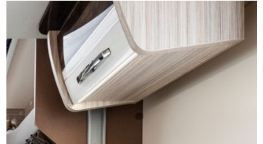
Paneles anticondensación separados de la pared en la zona de día y la zona de descanso para que circule el aire y el calor.
